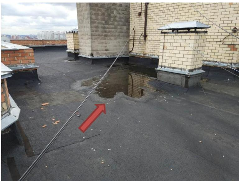
3. Окрытие парапета и элементов кровли, выполненное из листов оцинкованной стали, во многих местах не закреплено, имеет отверстия и открытые участки. Отсутствует фальцевое соединение и уклон металла. В результате образуются застои воды на металле и насыщение водой кирпичных парапетов.
