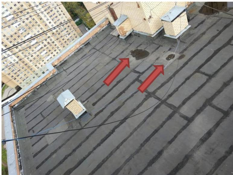
4. В «пироге» кровли присутствует вода, попавшая туда через негерметичные гидроизоляционные слои.
