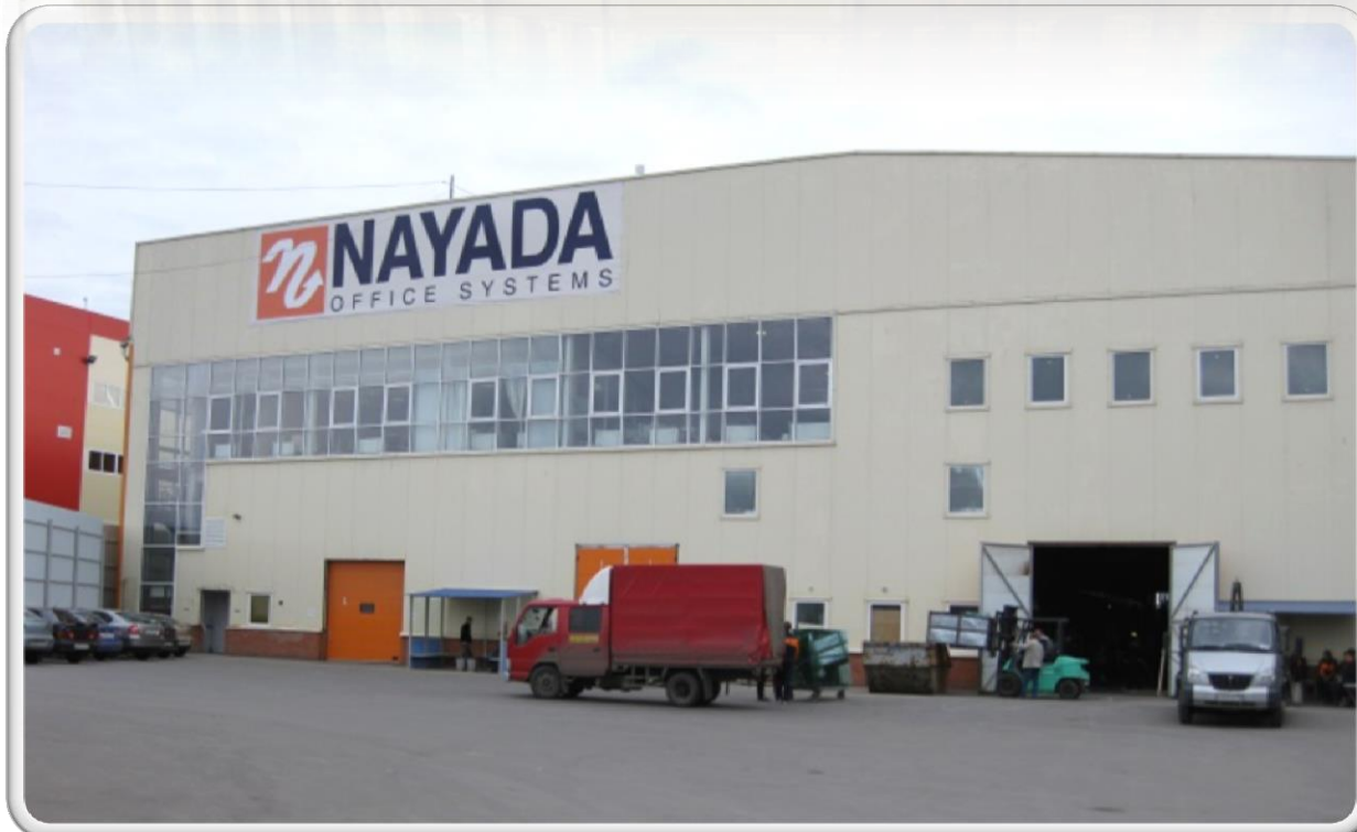
Производственно-складской комплекс «Наяда», М.О.,Домодедовский р-н, с.Ям
