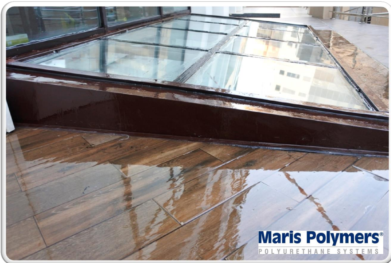
БЦ «Трайбека», гидроизоляция зенитных фонарей и плитки
