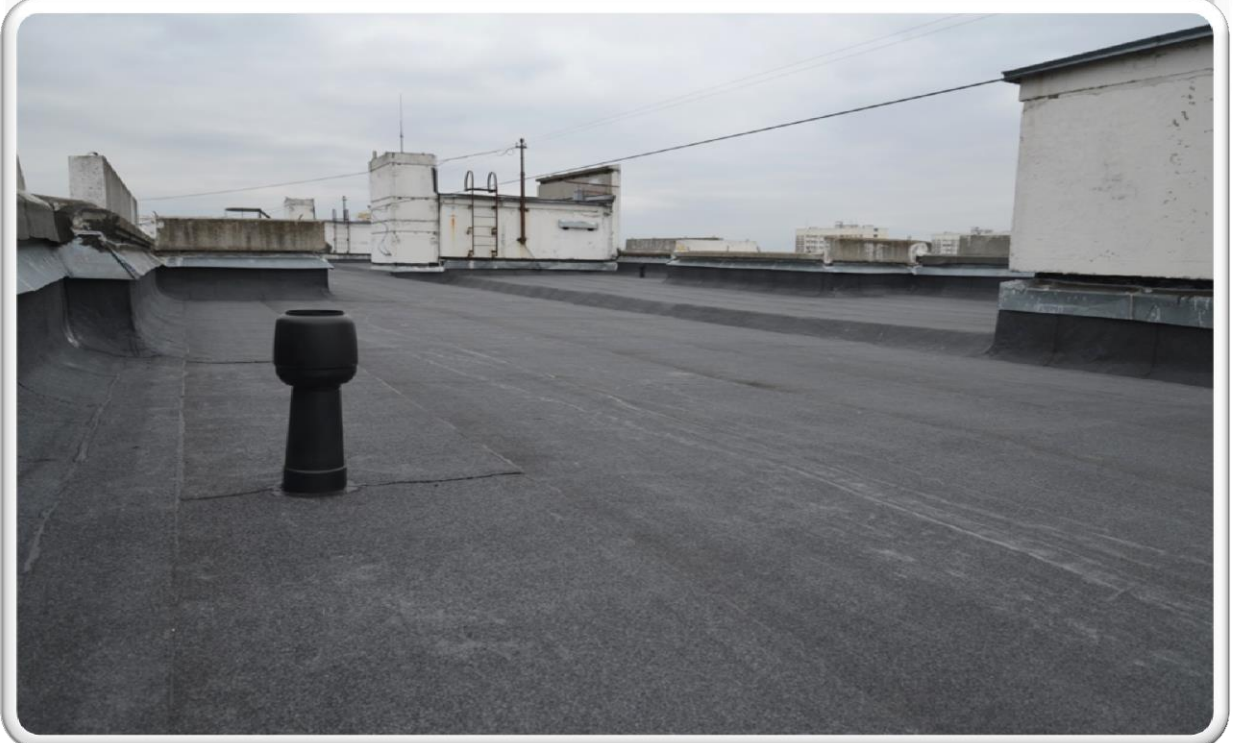
Ремонт кровли жилого дома, г.Москва, ул.Новомарьинская
