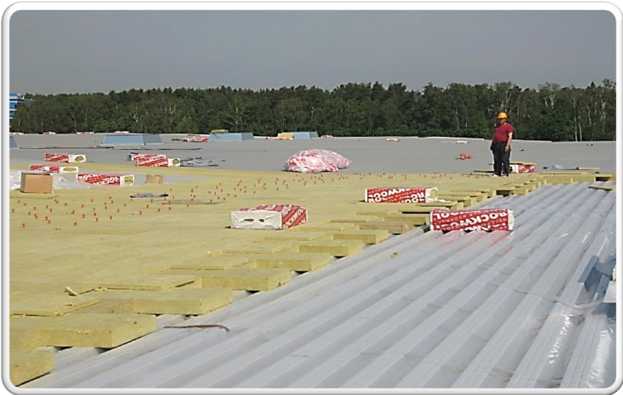
Складской комплекс «Тойота», пересечение Алтуфьевского шоссе с МКАД, 33 000 м.кв.
