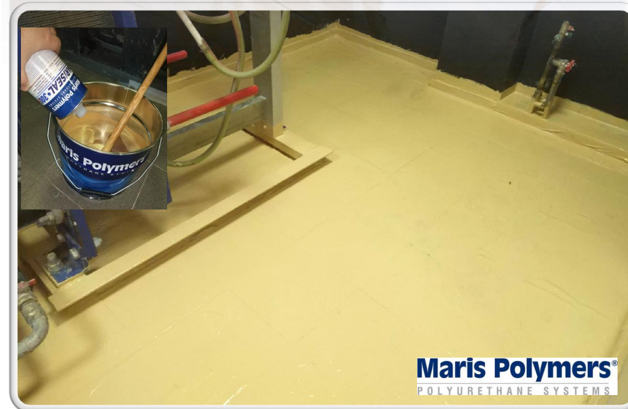
Гидроизоляция пола технического этажа жилого здания
